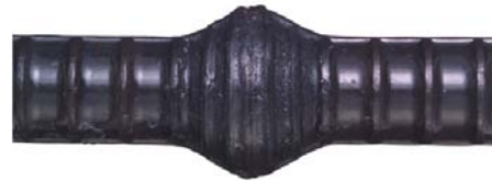
写真2 圧接継手（一例）
