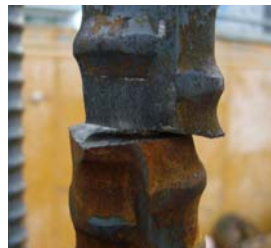
圧接端面の不良例 (シャーパー切断のまま)
